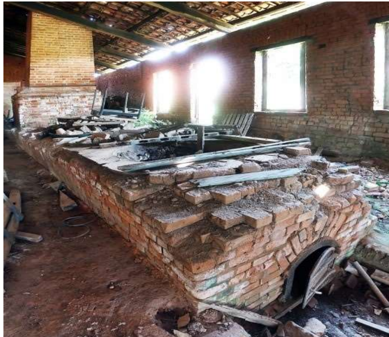
Modelo de estrutura para caldeira e boca fornalha moderna, que ocupava vários tachos. Modelo de engenho mais recente
