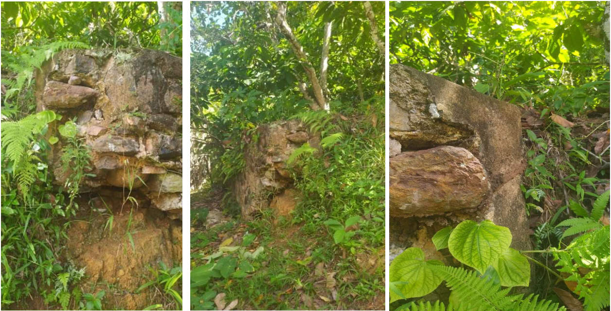
Estruturas do aqueduto que transplantava água para o Engenho de Santana através de calhas, no fundo da atual escola
